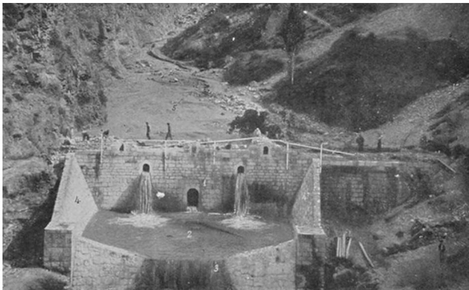
Figura 1. Hidrotecnia transversal de maçoneria hidràulica en construcció (ca. 1907). Torrent d'Enseu, Gerri de la Sal (T.M. Baix Pallars, Pallars Sobirà). Font: Fototeca Forestal (INIA)
